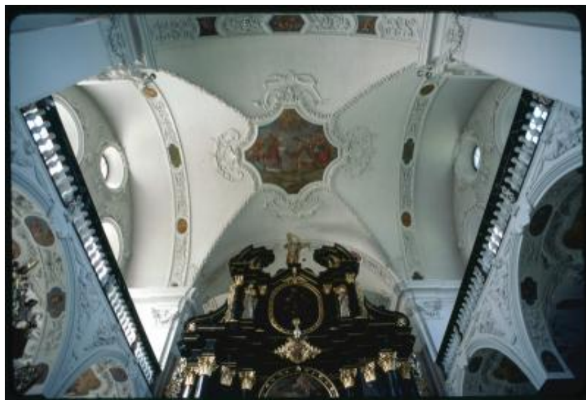
Pfäfers. Dettaglio del soffitto in corrispondenza dell'altare nella chiesa dell'abbazia
