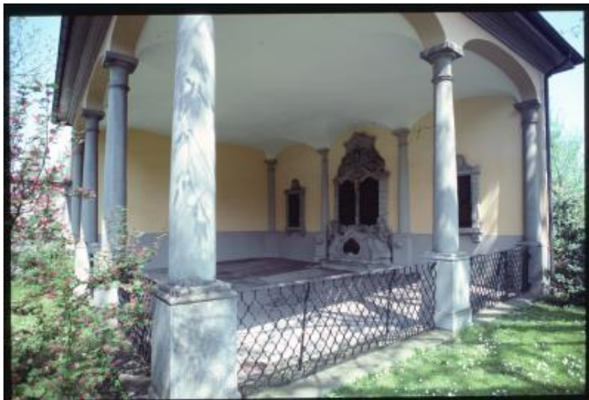
Rorschach. Loggiato sul retro della chiesa di St. Kolumban
