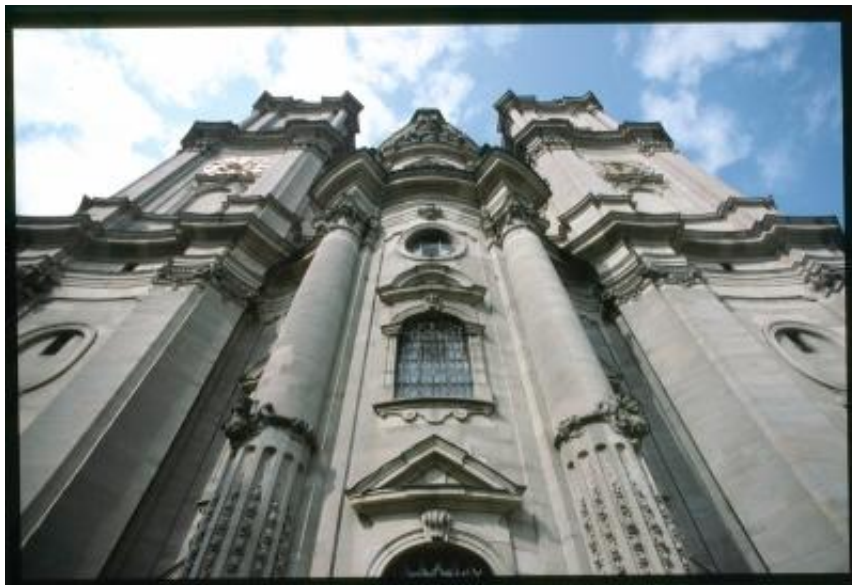
San Gallo. Abside della chiesa dell'abbazia vista dall'esterno
