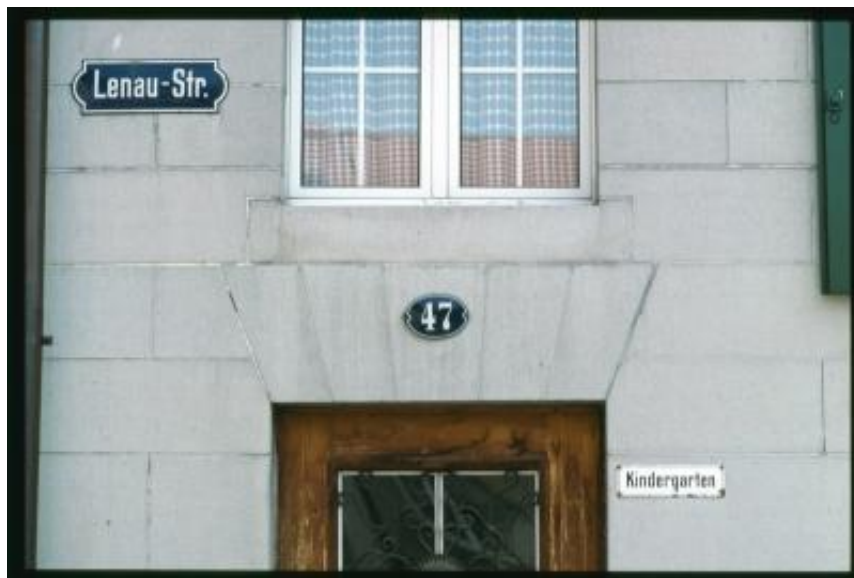
San Gallo. Dettaglio della facciata della scuola materna dello Schorensiedlung
