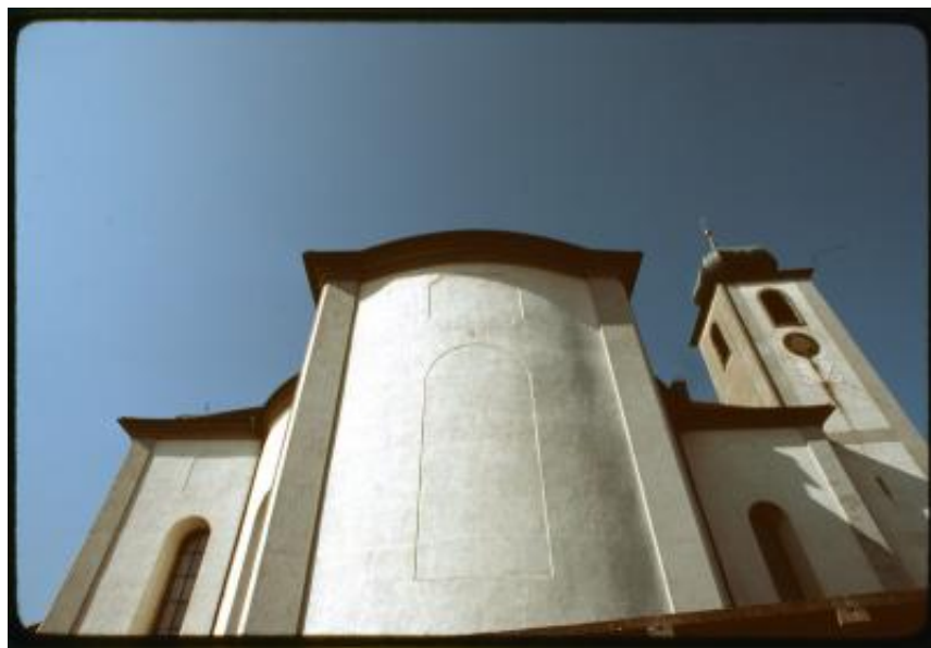
Waldkirch. Parte absidale della chiesa di St. Johannes Baptist a Bernhardzell vista dall'esterno
