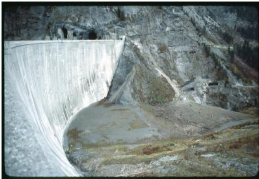
Calfeisental. Veduta della diga di Gigerwald
