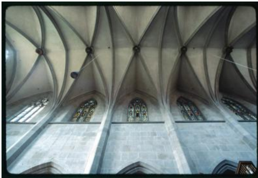
Kappel am Albis. Dettaglio delle volte a crociera della chiesa del convento
