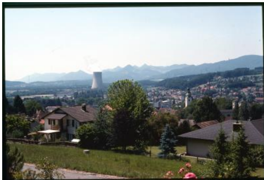
La centrale nucleare di Gösgen vista da Schönenwerd
