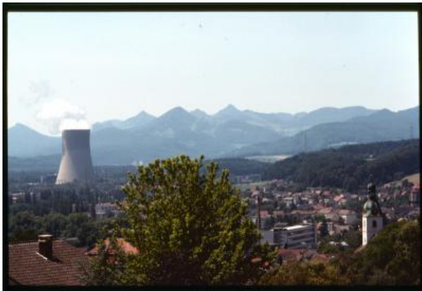
La centrale nucleare di Gösgen vista da Schönenwerd
