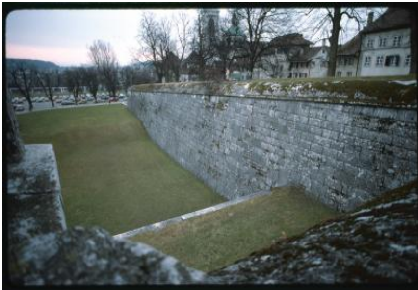
Soletta. Dettaglio delle mura della città nell'area dei Bastioni di Riedholtz
