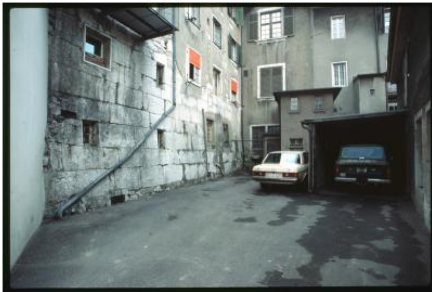
Soletta. Dettaglio di un muro antico successivamente inglobato in un edificio
