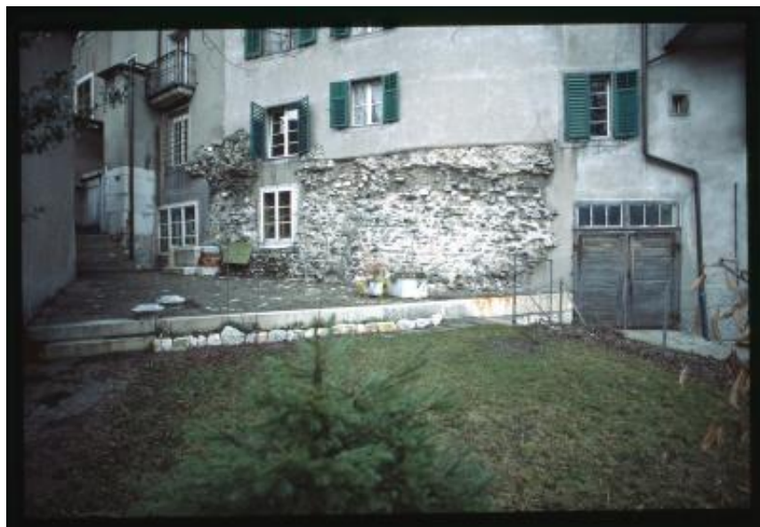
Soletta. Veduta di un muro antico successivamente inglobato in un edificio
