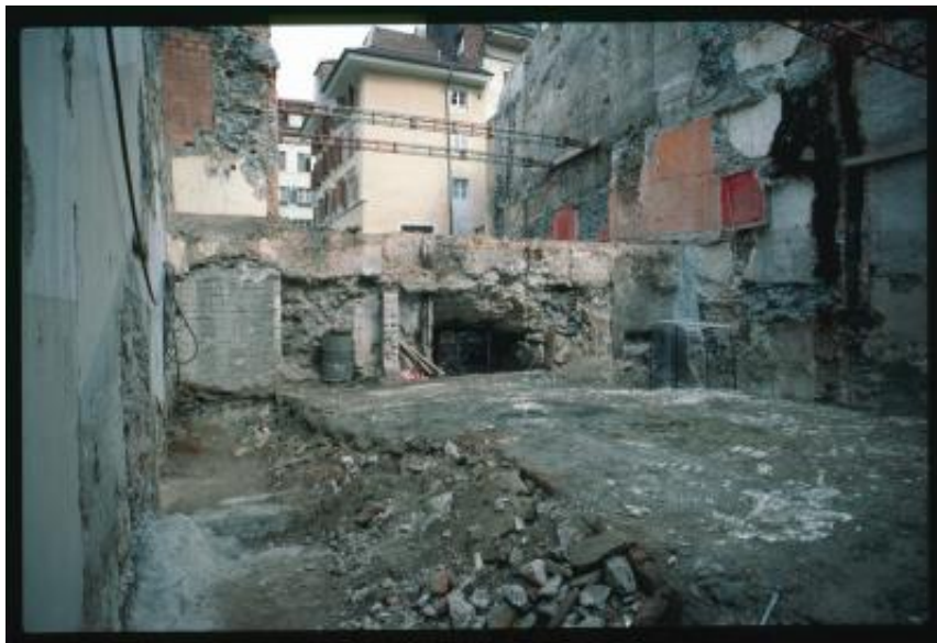
Soletta. Dettaglio di un muro antico visibile fra i resti di un edificio demolito sulla Gerbergasse
