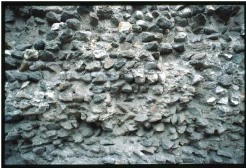
Soletta. Dettaglio di un muro antico successivamente inglobato in un edificio sulla Löwengasse
