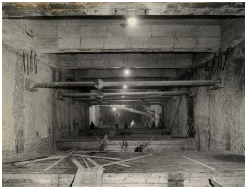
Lavori in sotterraneo nella galleria tra le stazioni metropolitane Oberdan e Palestro a Milano
