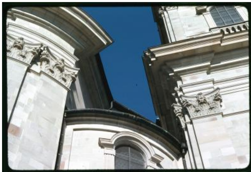
Einsiedeln. Dettaglio della facciata della chiesa del monastero
