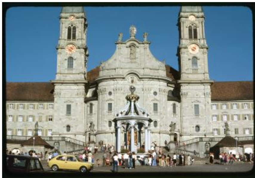
Einsiedeln. Veduta della facciata della chiesa del monastero
