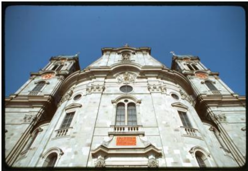
Einsiedeln. La facciata principale della chiesa del monastero vista dal basso
