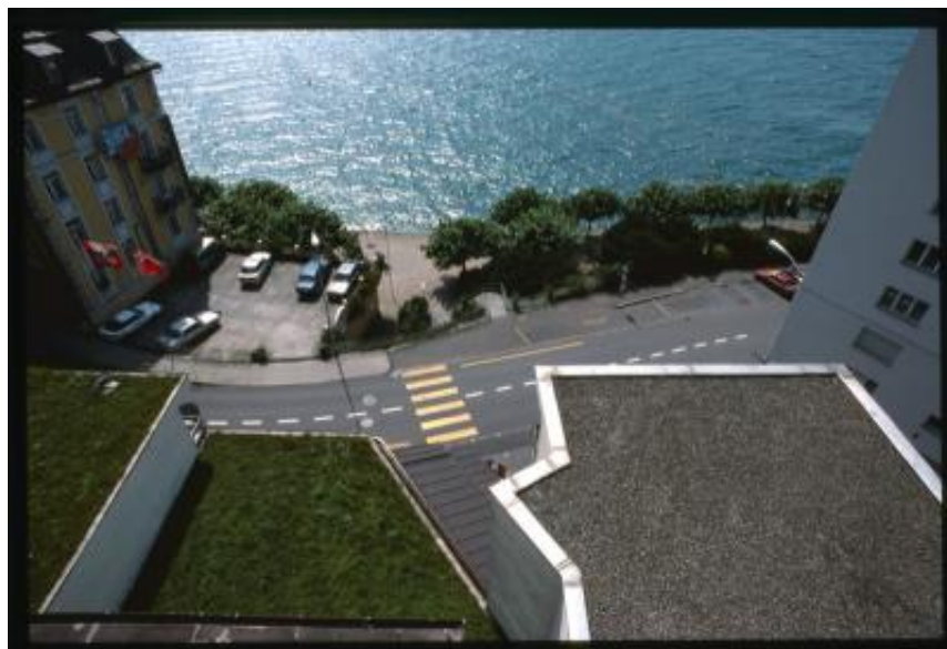
Ingenbohl. Scorcio del lungolago visto da un edificio nella frazione di Brunnen
