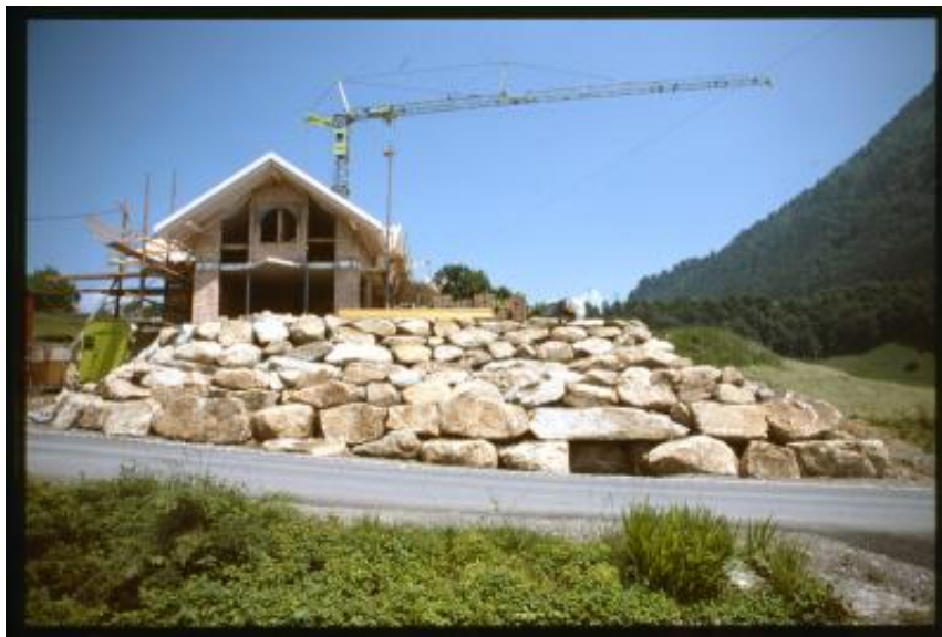
Morschach. Veduta di una villetta in costruzione
