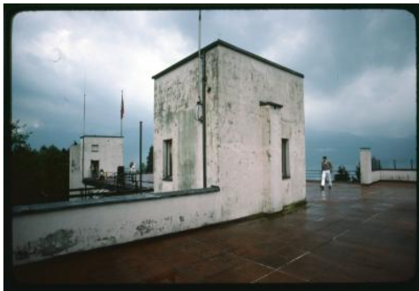
Veduta del tetto terrazzato dell'Hotel Bauhaus
