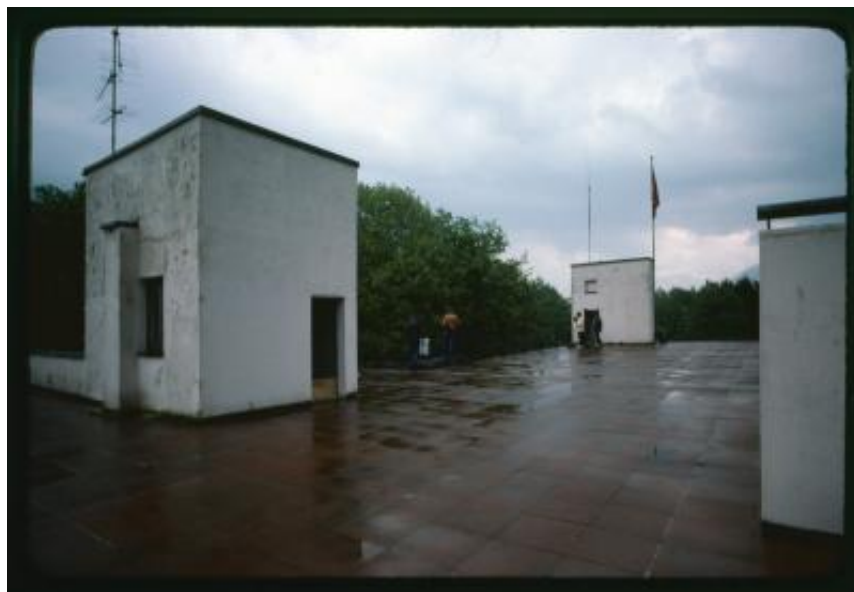
Veduta del tetto terrazzato dell'Hotel Bauhaus
