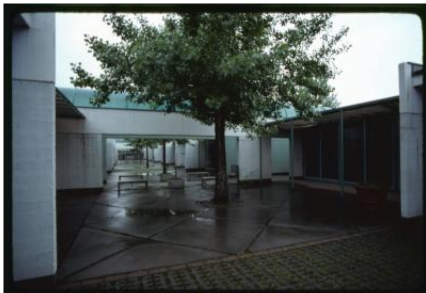
Veduta del cortile interno della scuola elementare Ai Saleggi
