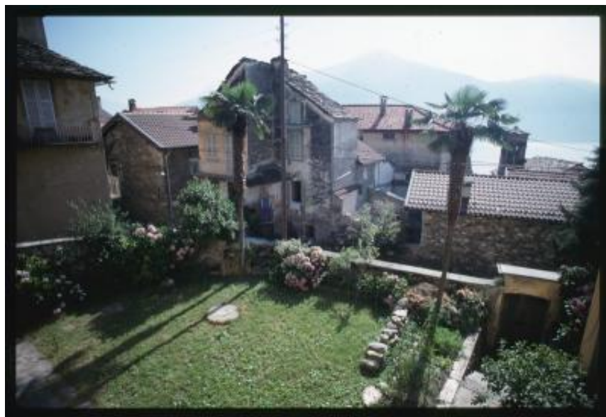
Veduta del centro storico di Ronco sopra Ascona
