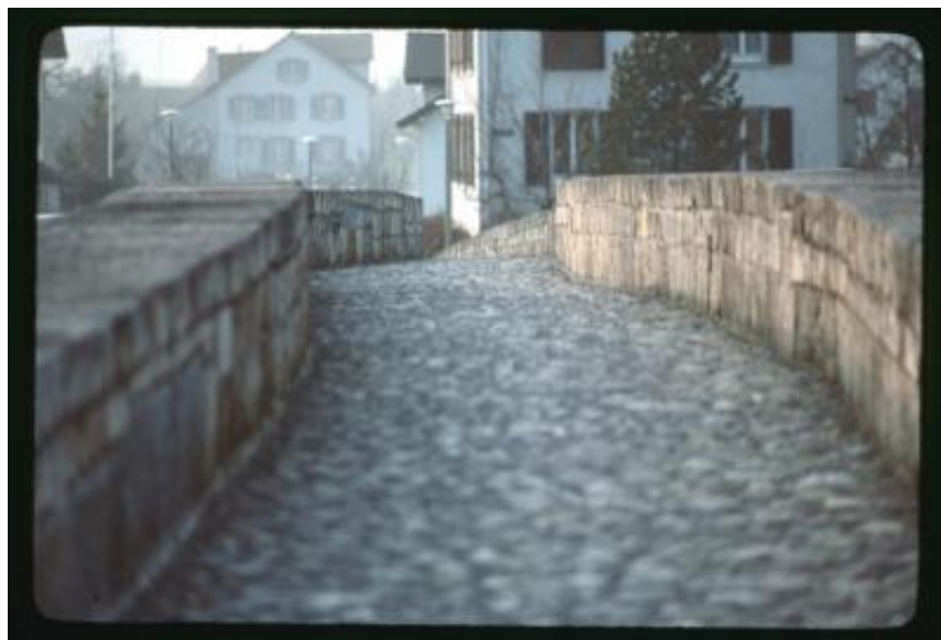
Bischofszell. Dettaglio del ponte storico sul fiume Thur
