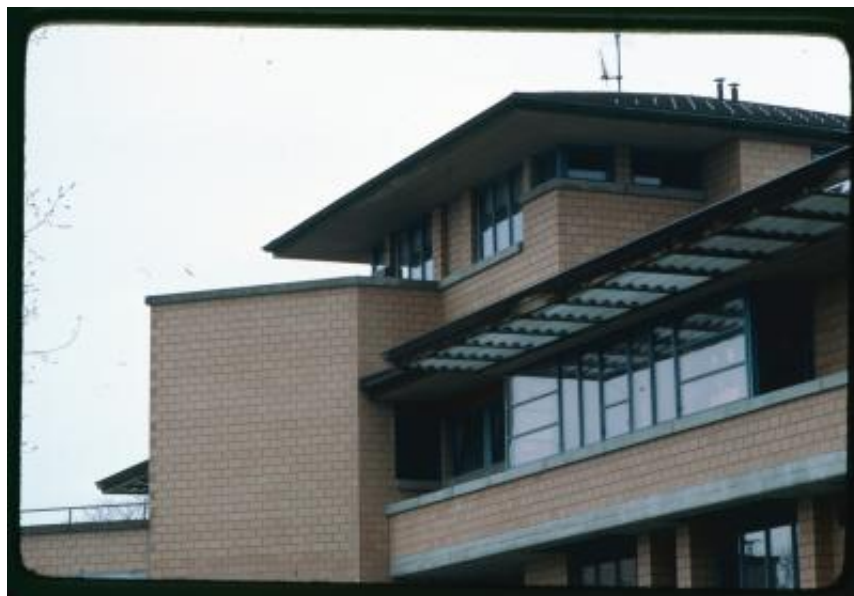
Herdern. Dettaglio della parte superiore di un edificio scolastico
