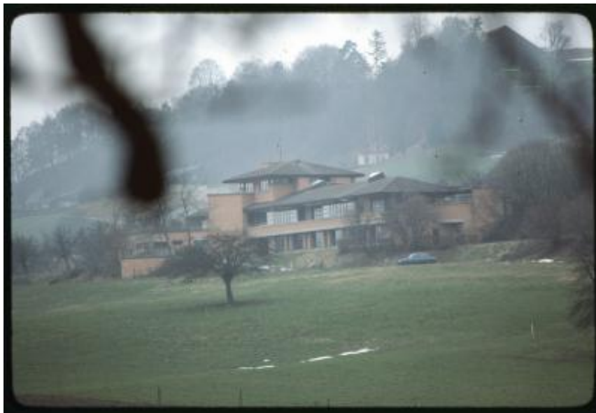
Herdern. Edificio scolastico circondato da un parco
