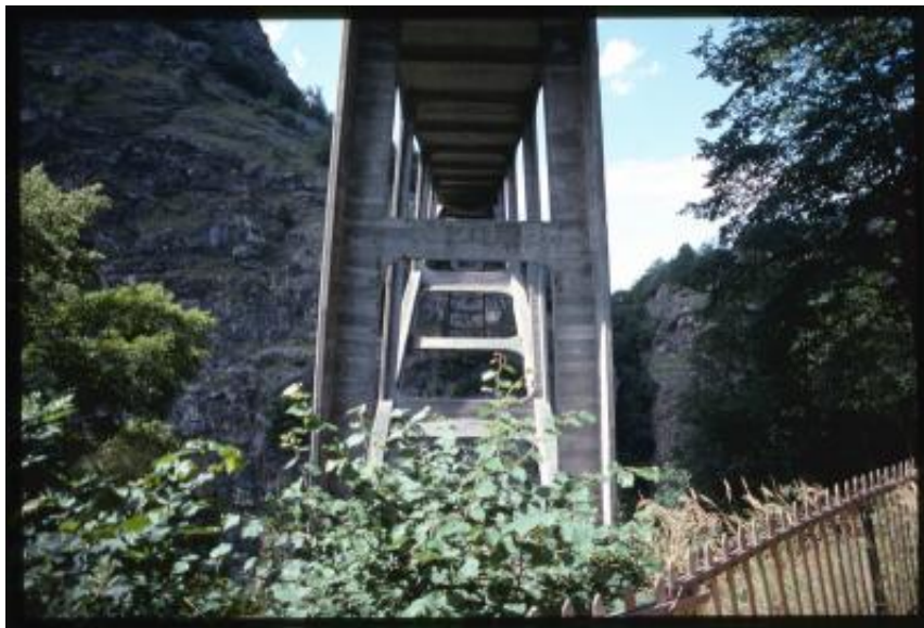
Martigny. Dettaglio dei pilastri del Pont du Gueuroz
