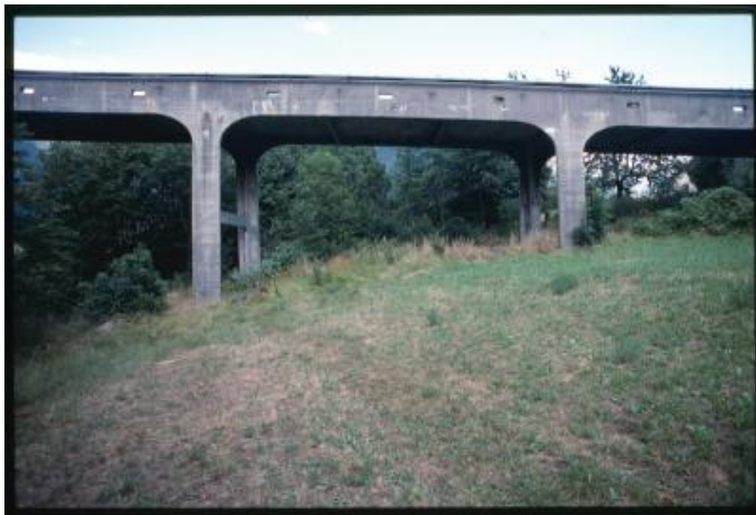
Martigny. Viadotto del Pont du Gueuroz
