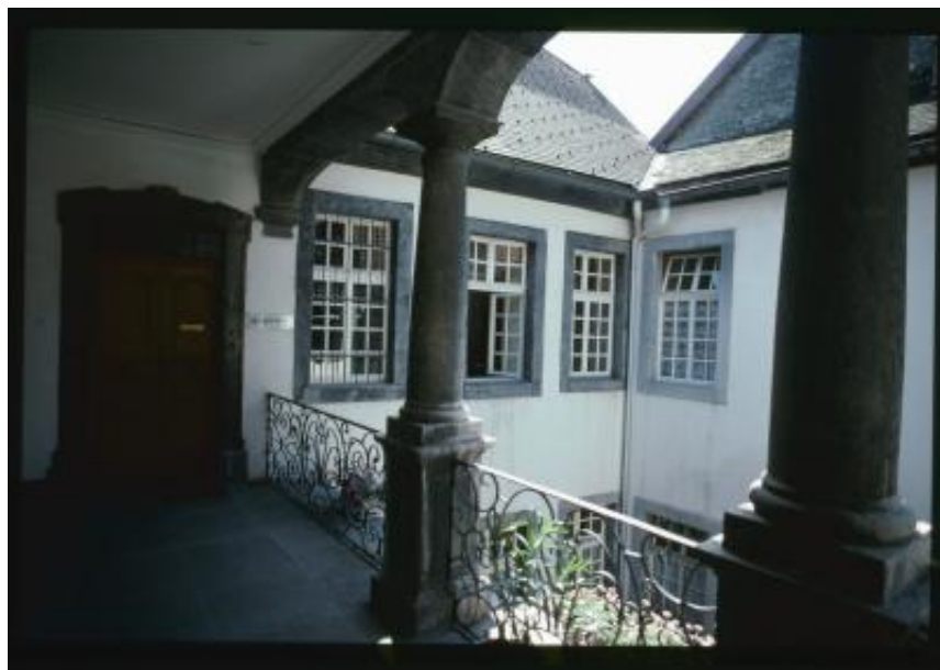
Saint-Maurice. Dettaglio del loggiato della Maison de la Pierre
