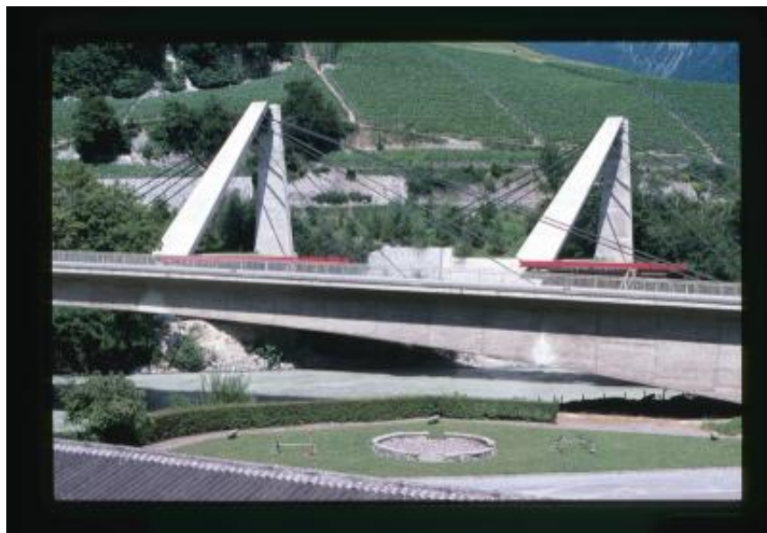
Saint-Maurice. Veduta di un ponte
