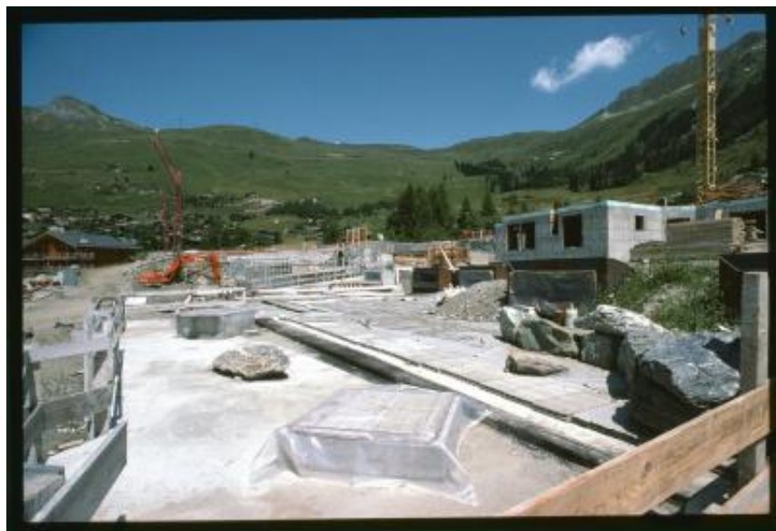
Verbier. Veduta di un cantiere in Hameau de Verbier
