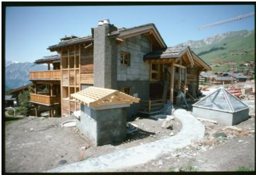
Verbier. Lavori edili ad uno chalet in Hameau de Verbier
