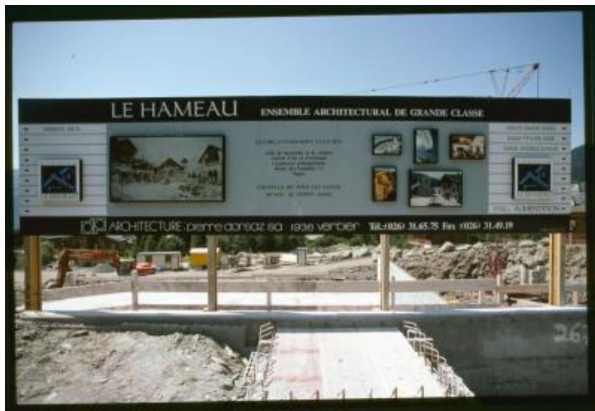
Verbier. Cartello di cantiere in Hameau de Verbier
