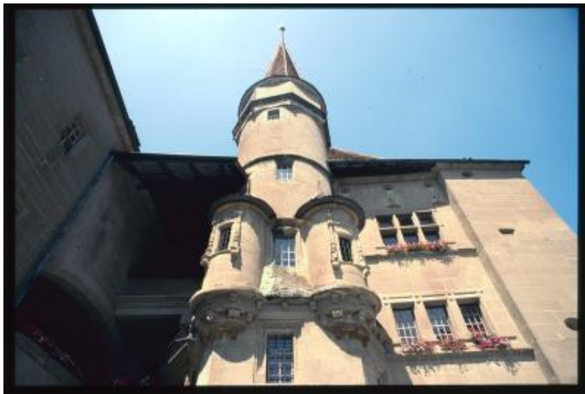
Avenches. Torre del Castello
