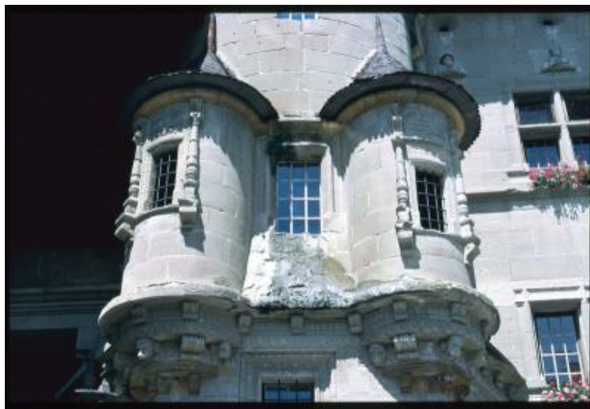
Avenches. Dettaglio della torre del Castello
