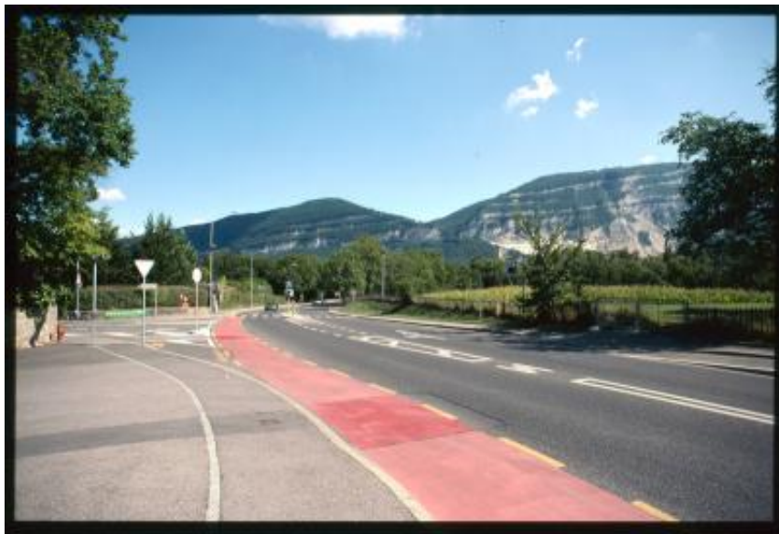
Bourg-en-Lavaux. Veduta di una strada nella frazione Villette
