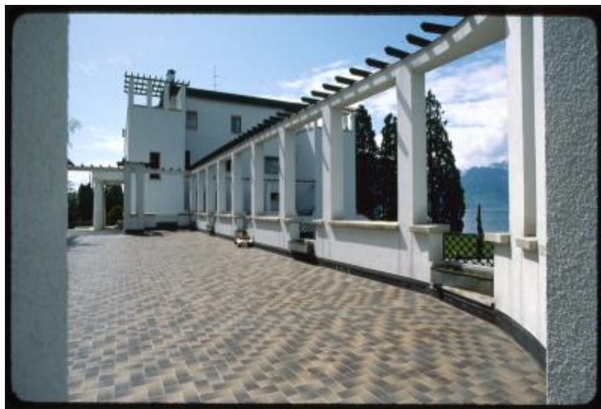
Montreux. Veduta della pergola di Villa Karma
