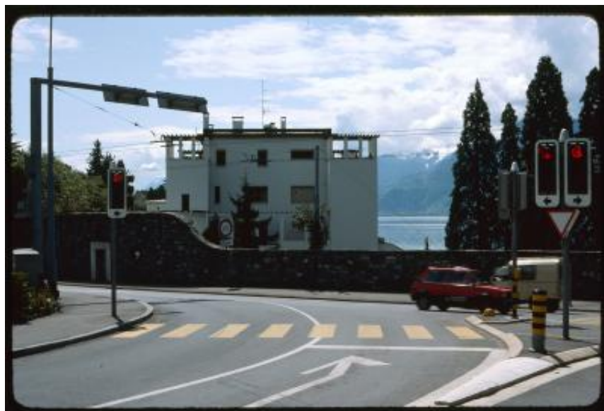
Montreux. Villa Karma vista dalla strada
