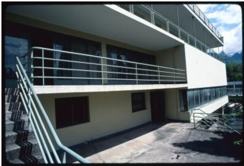
Montreux. Facciata ovest di Villa Kenwin
