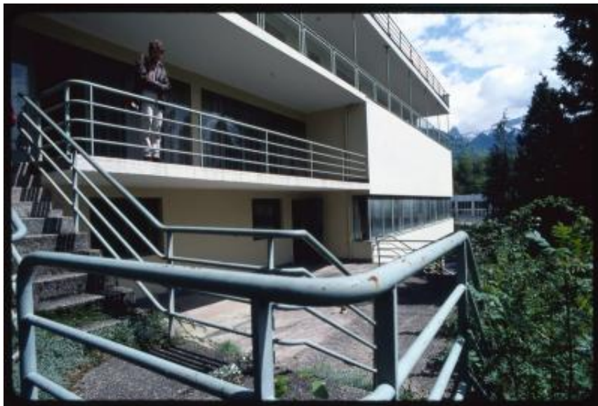
Montreux. Facciata ovest di Villa Kenwin
