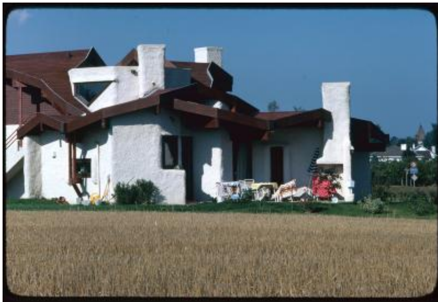
Commugny. Casa vista dal lato del giardino
