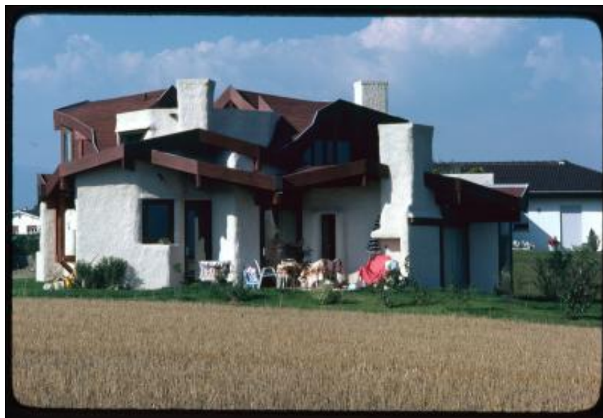
Commugny. Casa vista dal lato del giardino
