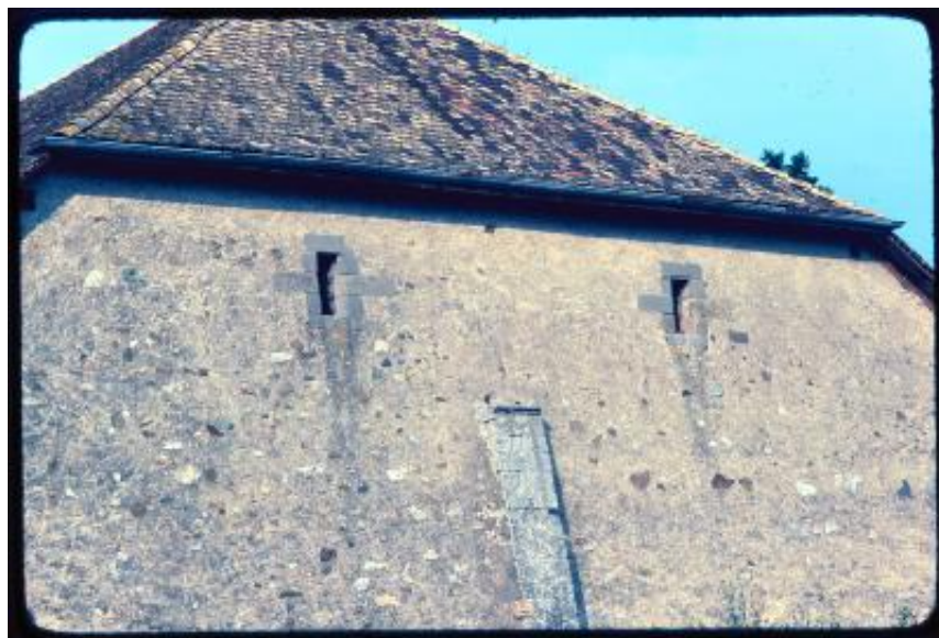
Coppet. Dettaglio di una fattoria nei pressi della stazione
