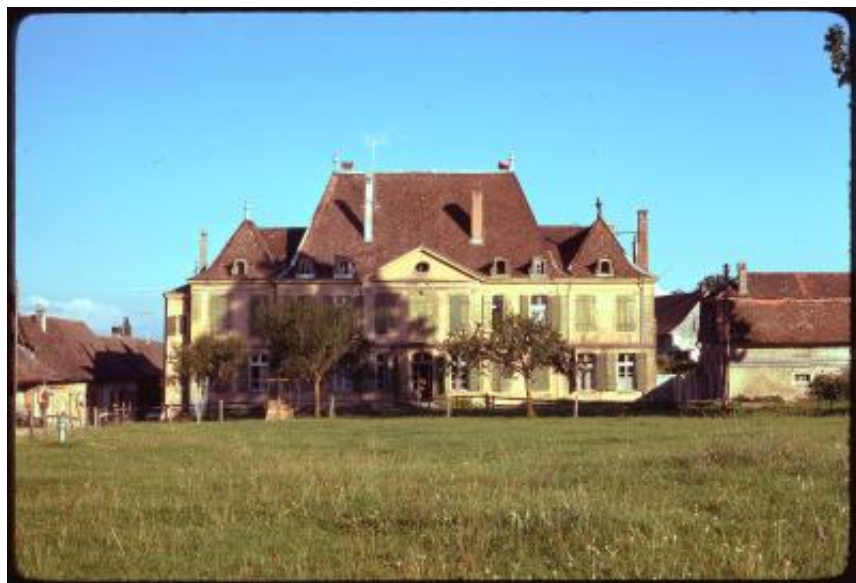
Grandcour. Facciata posteriore del castello
