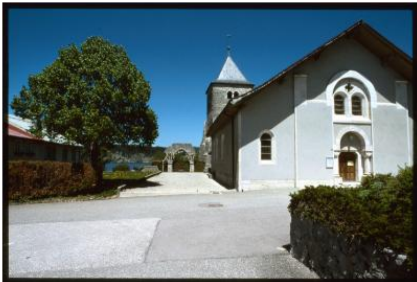
L'Abbaye. Veduta della Chiesa riformata con la Torre Aymon e le vestigia di un arco gotico
