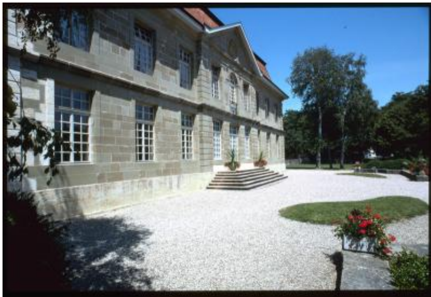
L'Isle. Facciata del castello vista lateralmente
