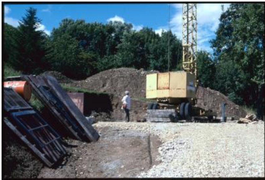
Montilliez. Cantiere edile nella frazione di Naz
