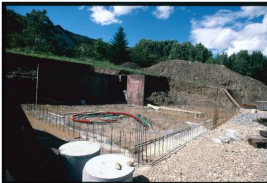
Montilliez. Cantiere nella frazione di Naz
