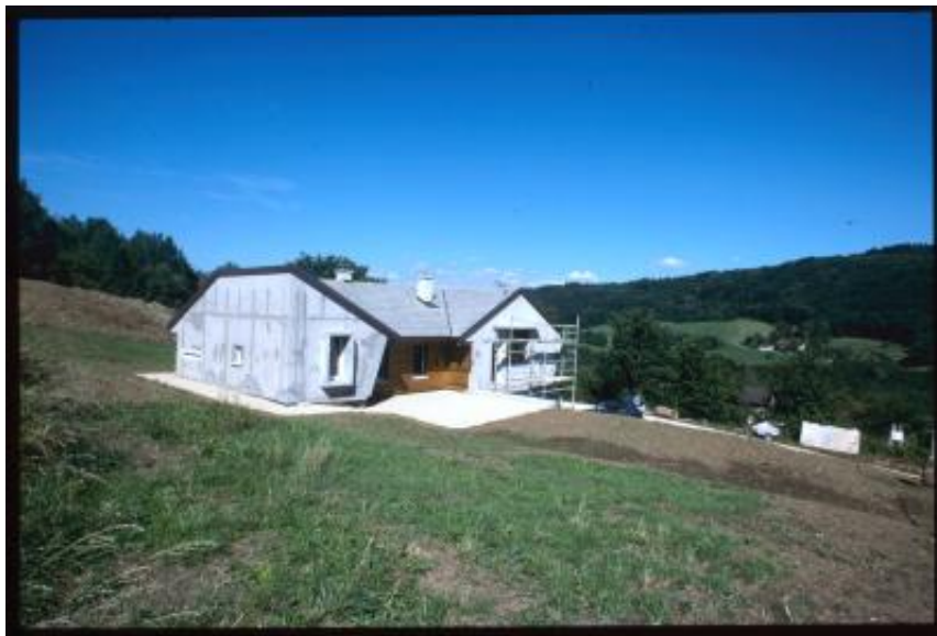
Montilliez. Casa in costruzione nella frazione di Naz
